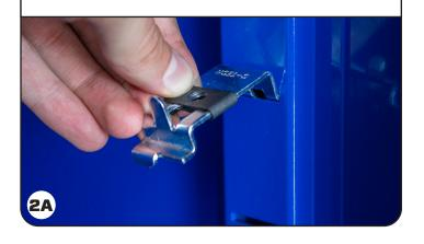
ROTATE BRACKET DOWN SO THAT BOTTOM PRONG RESTS INSIDE THE SLOT IMMEDIATELY BELOW.
